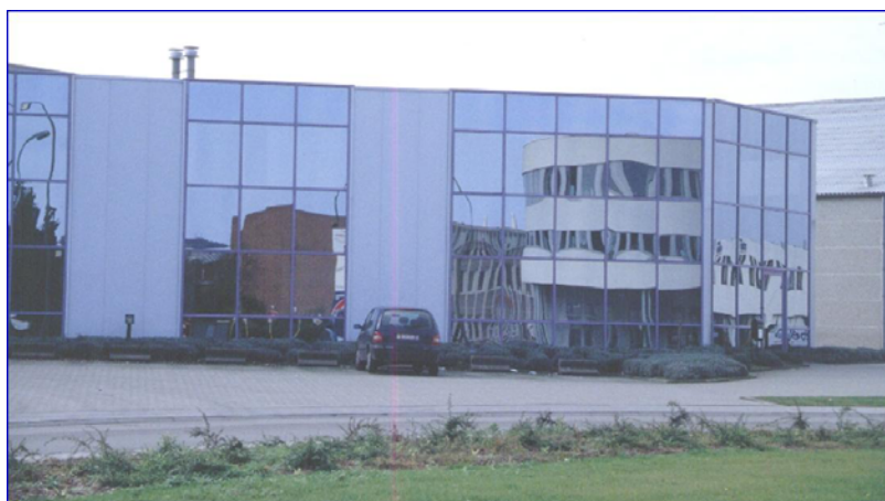
Figuur 21: Vervormde weerspiegeling.
